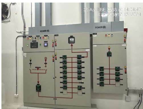
รูปที่ 7 ตู้ควบคุมสำหรับระบบบำบัด
